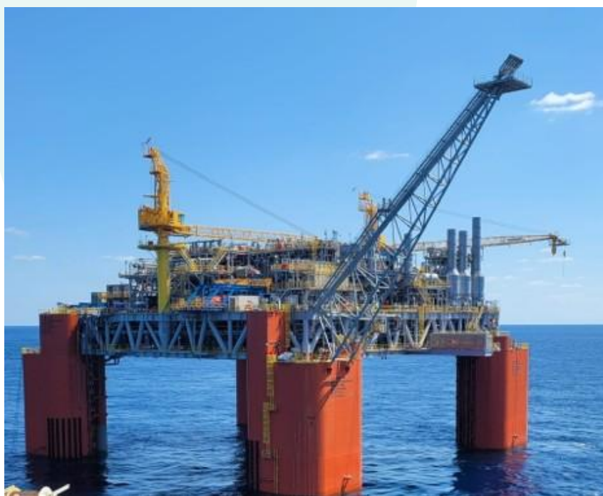
מתקן הטיפול וההפקה של הפרויקט Floating Production System
